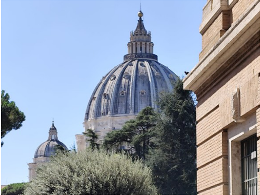
Figura 5. Detalhe aos anéis de compressão na cúpula externa da Basílica, vista do Museu do Vaticano
