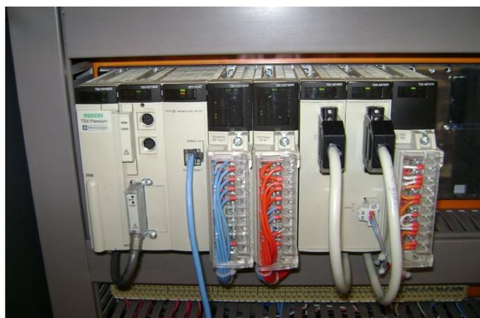
**Figura 4. 1 – CLP *Schneider Electric- Telemecanique* instalado no painel de comando e proteção**
