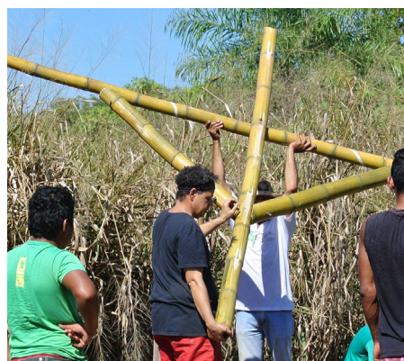
Diagonales fijadas con varilla roscada.
