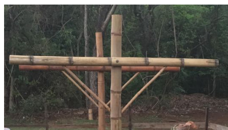
Diagonales fijadas con tornillos.
