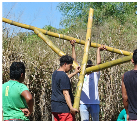
Diagonais fixadas com barra roscada.
