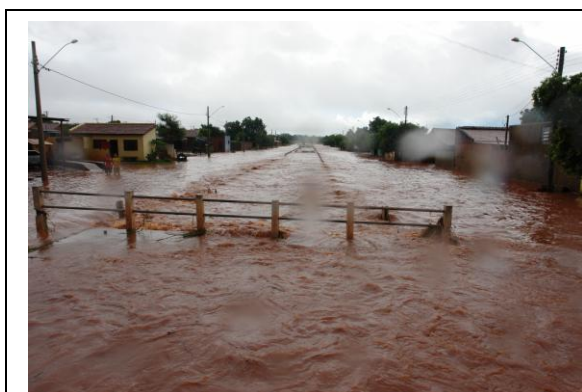
Figura 28 – Enchente no trecho canalizado do córrego Aviação, que corta cidade de Brasilândia, em 2006.
