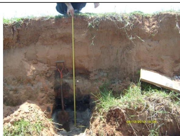
Figura 47 – Disposição das camadas no barranco à margem direita do córrego Aviação a jusante da malha urbana da cidade de Brasilândia.
