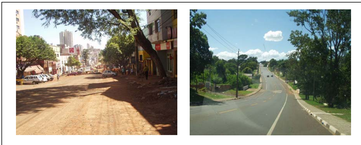
Figura 25: Obras de: reforma na Avenida Brasil e construção da Avenida Venezuela Foto: Clari Terezinha Hahn
