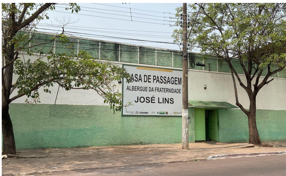
Imagem 1. Fachada da Casa de Passagem Albergue da Fraternidade José Lins.
