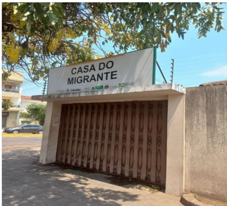
Imagem 2. Fachada da Casa do Migrante.
