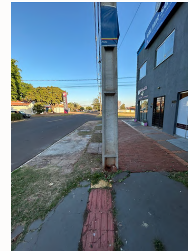
Figura 28: Piso tátil inadequado
