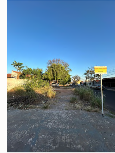
Figura 29: Calçamento e vegetação inadequados
