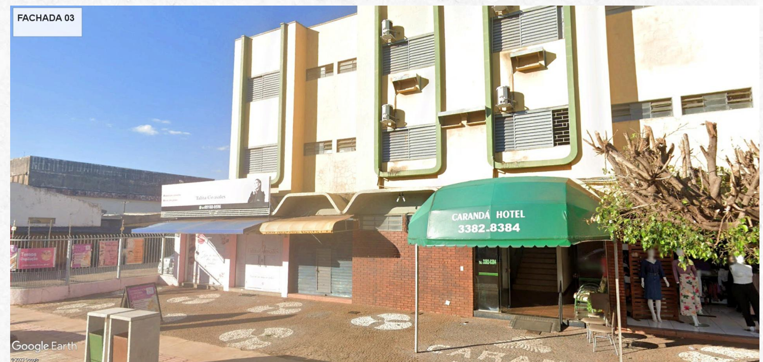
Figura 31: Fachada 03- R.Joaquim Nabuco
