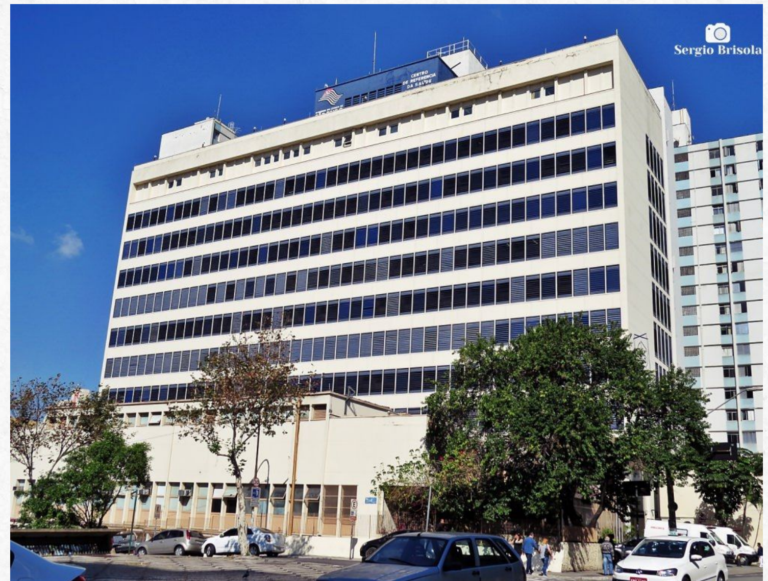
Figura 18: Fachada Principal Edifício Pérola Byington
