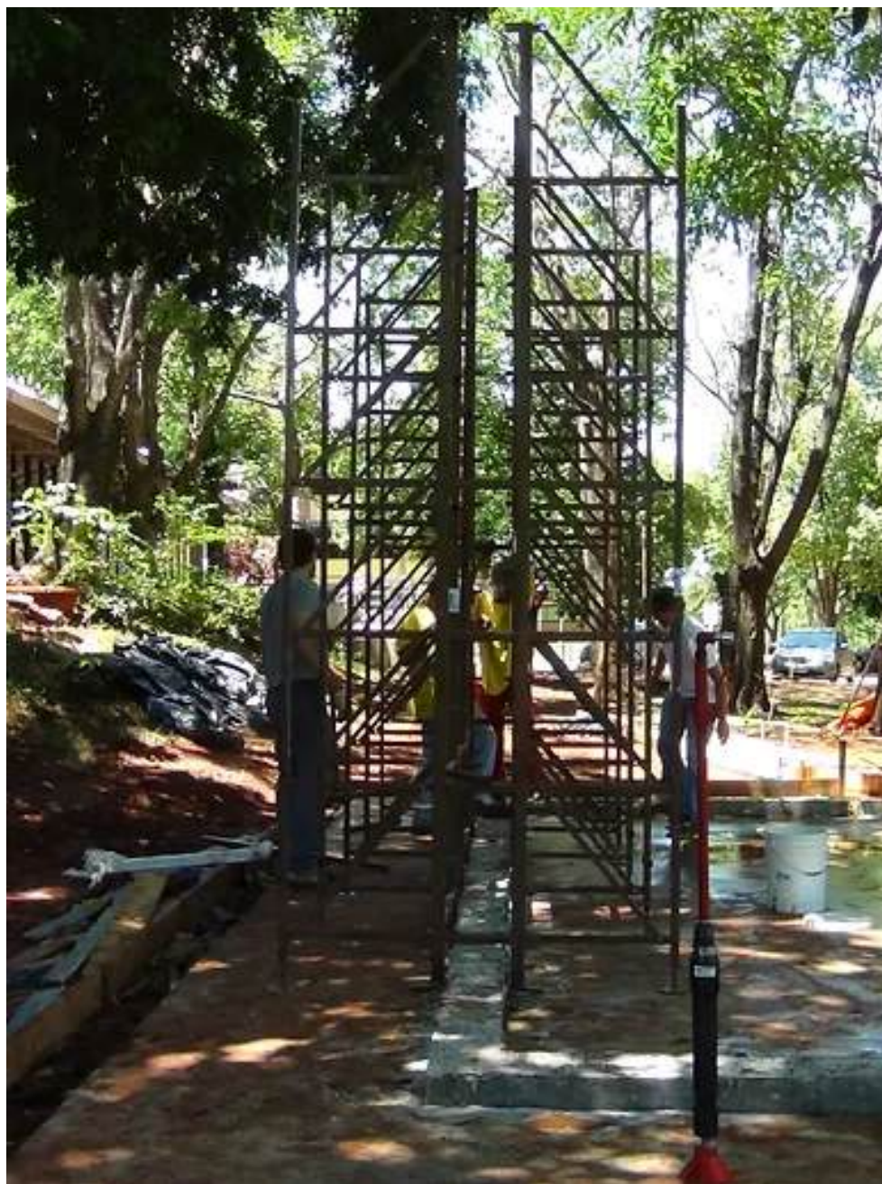
Figura 15. Montagem das formas (que também são andaimes) para execução das paredes
