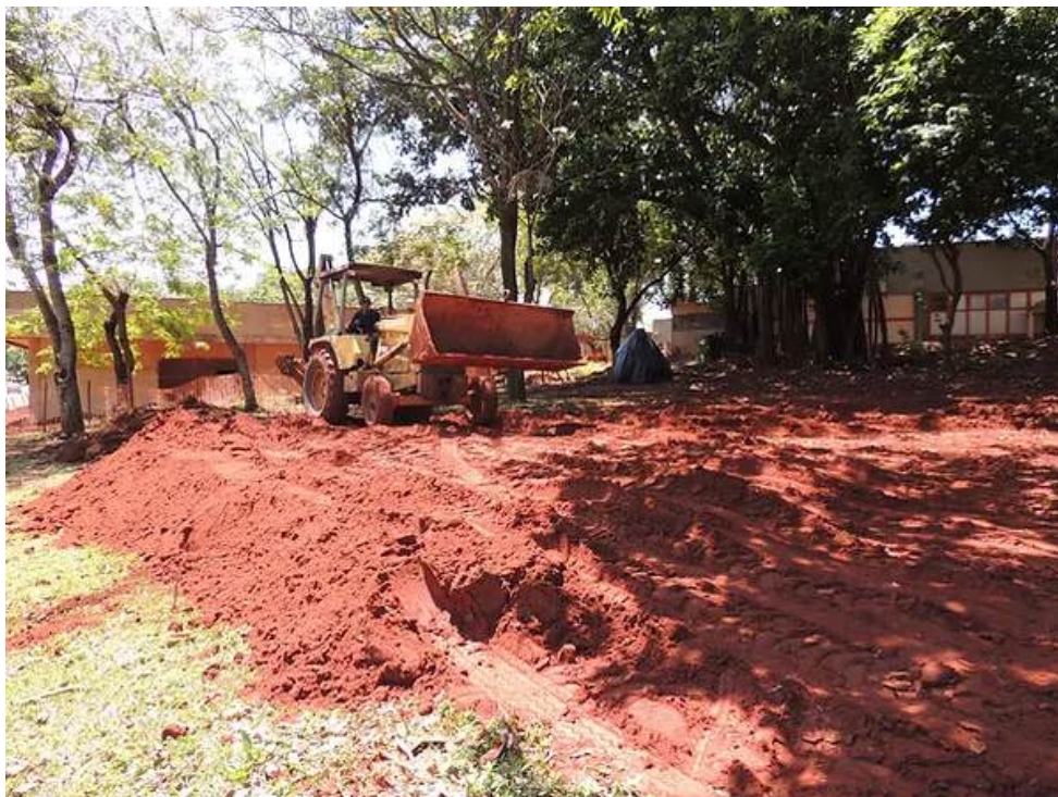
Figura 13. Execução do aterro
