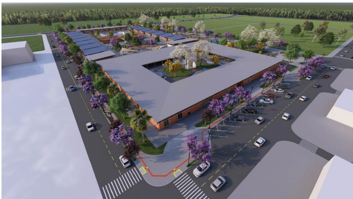
Figura 52. VISTA ESQUINA RUA CAMILO MERES X RUA ZÁKIA NAHAS SIUFI
