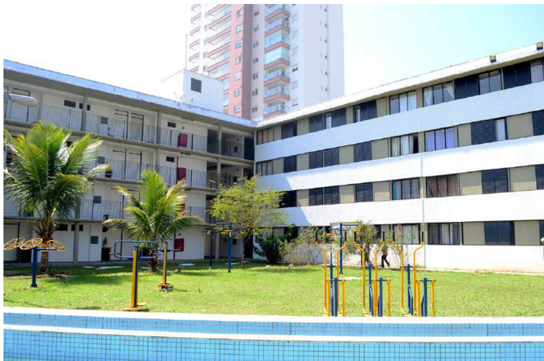
Figura 7. Fachadas internas da edificação
