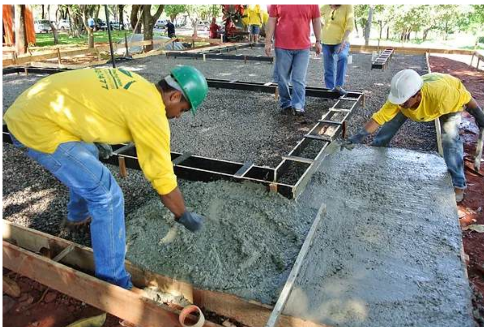
Figura 14. Concretagem do radier
