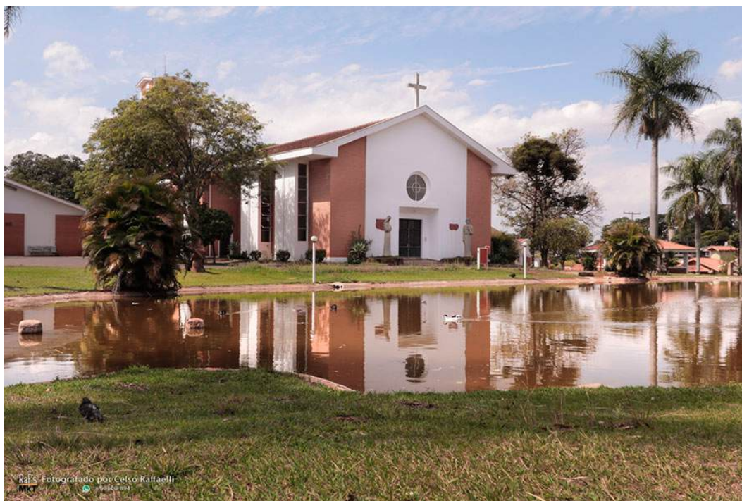
Figura 4. Vista do lago e Igreja do Lar dos Velinhos
