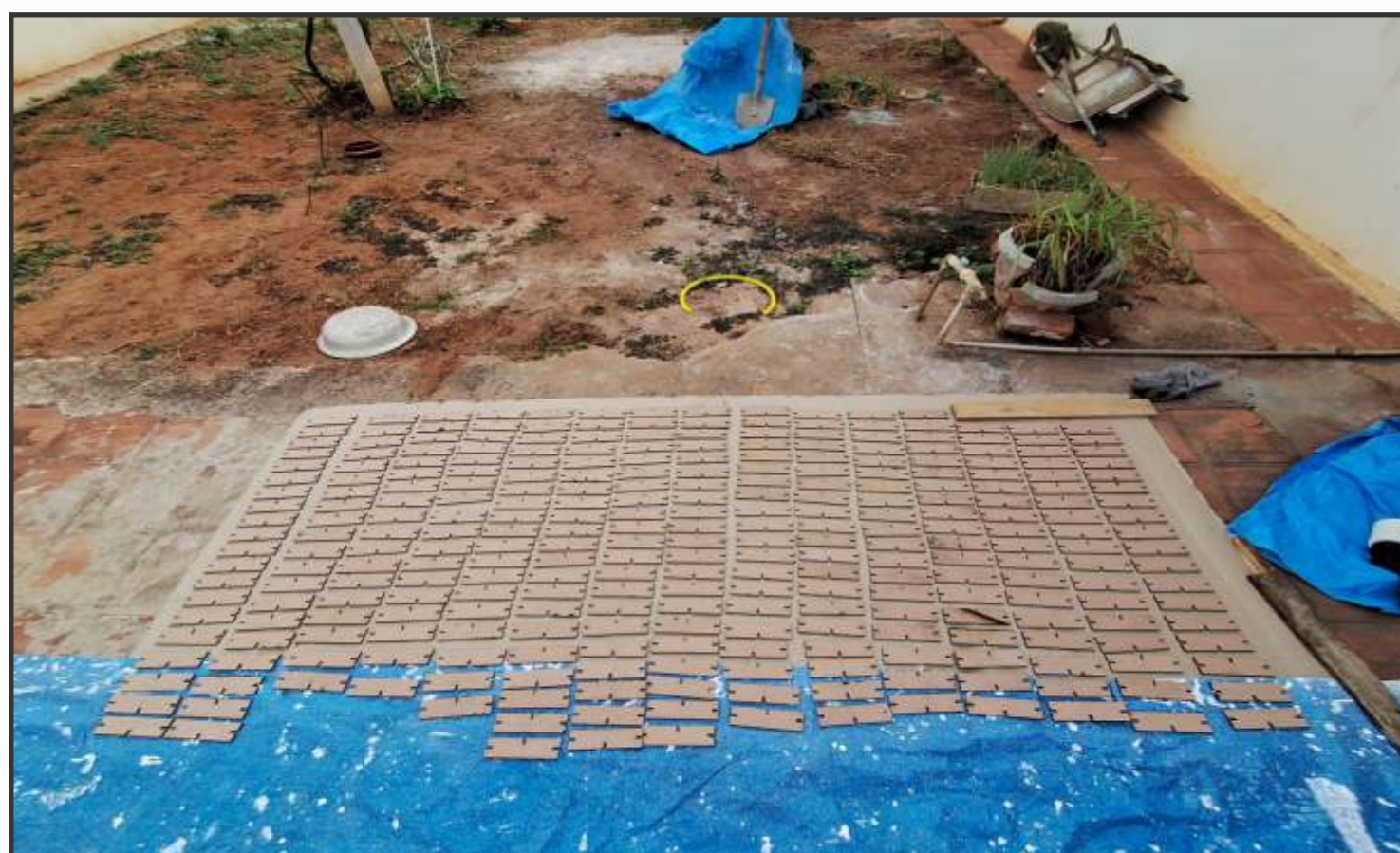
Figura 106: Peças posicionadas para receber a pintura
