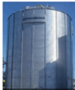
Fig. 2.21 – Silo (Kepler Weber, 2006)
