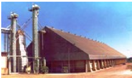
Fig. 2.13 – Armazém graneleiro (Casemg, 2006)
