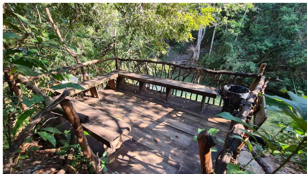
Figura 25 - Deck de madeira com acesso ao rio
