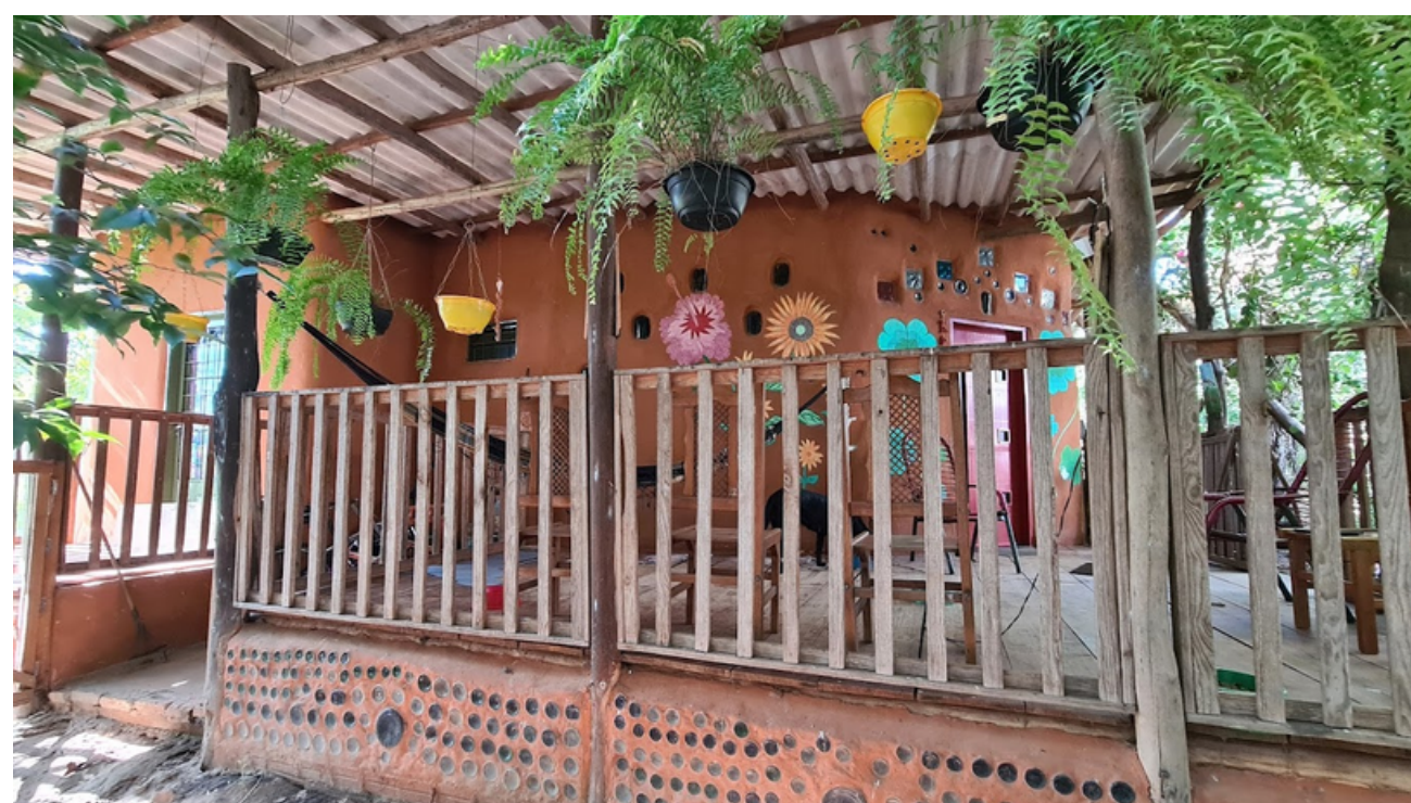
Figura 24 - Edificação de taipa de mão
