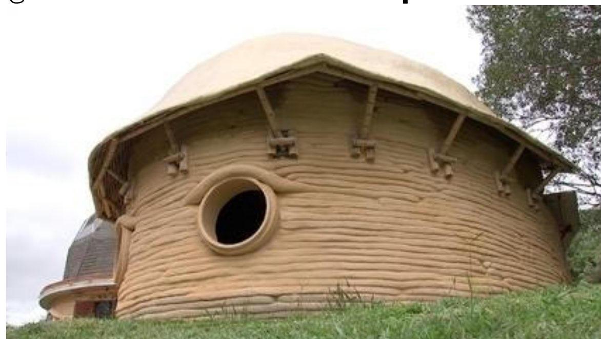
Figura 29 - Cobertura em cúpula de bambu
