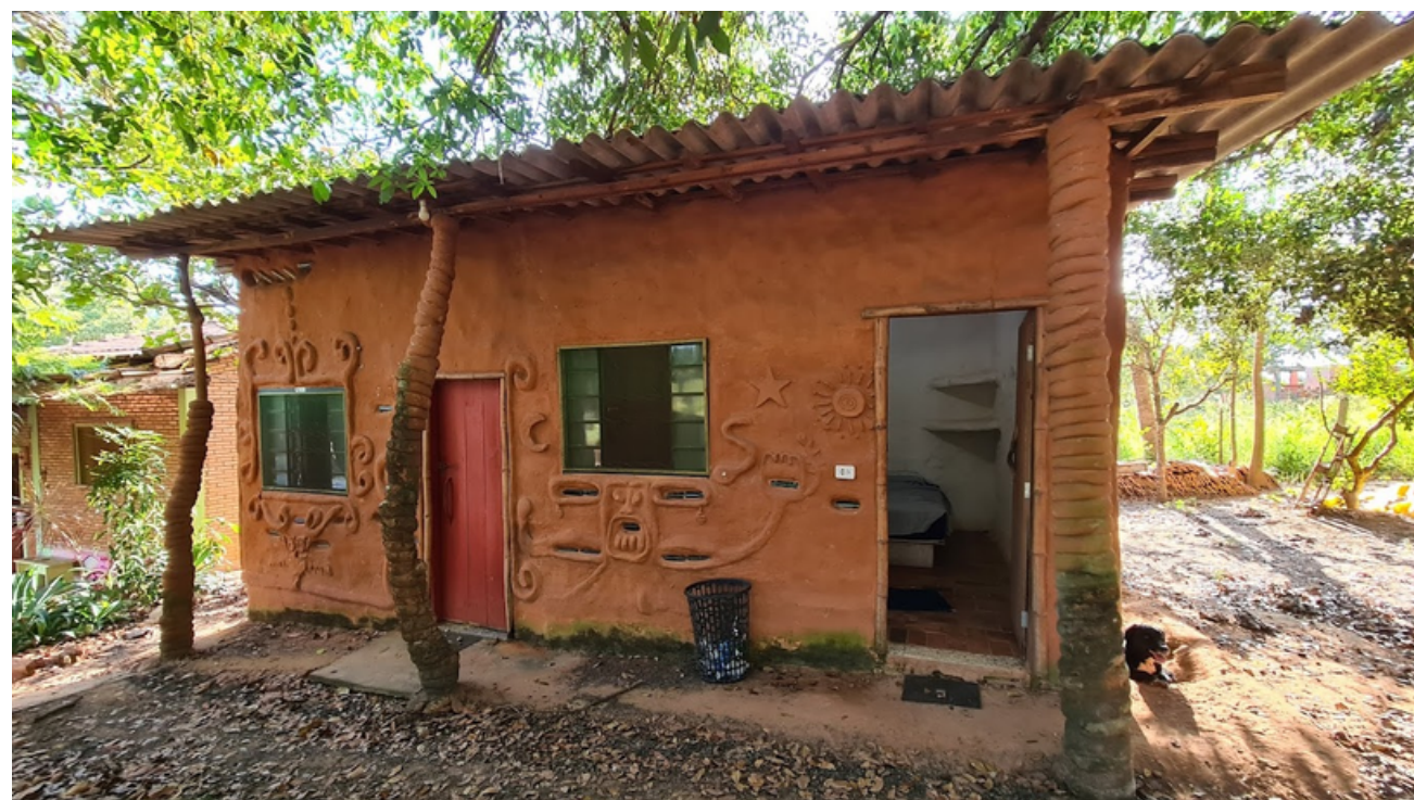
Figura 23 - Edificação de taipa de mão
