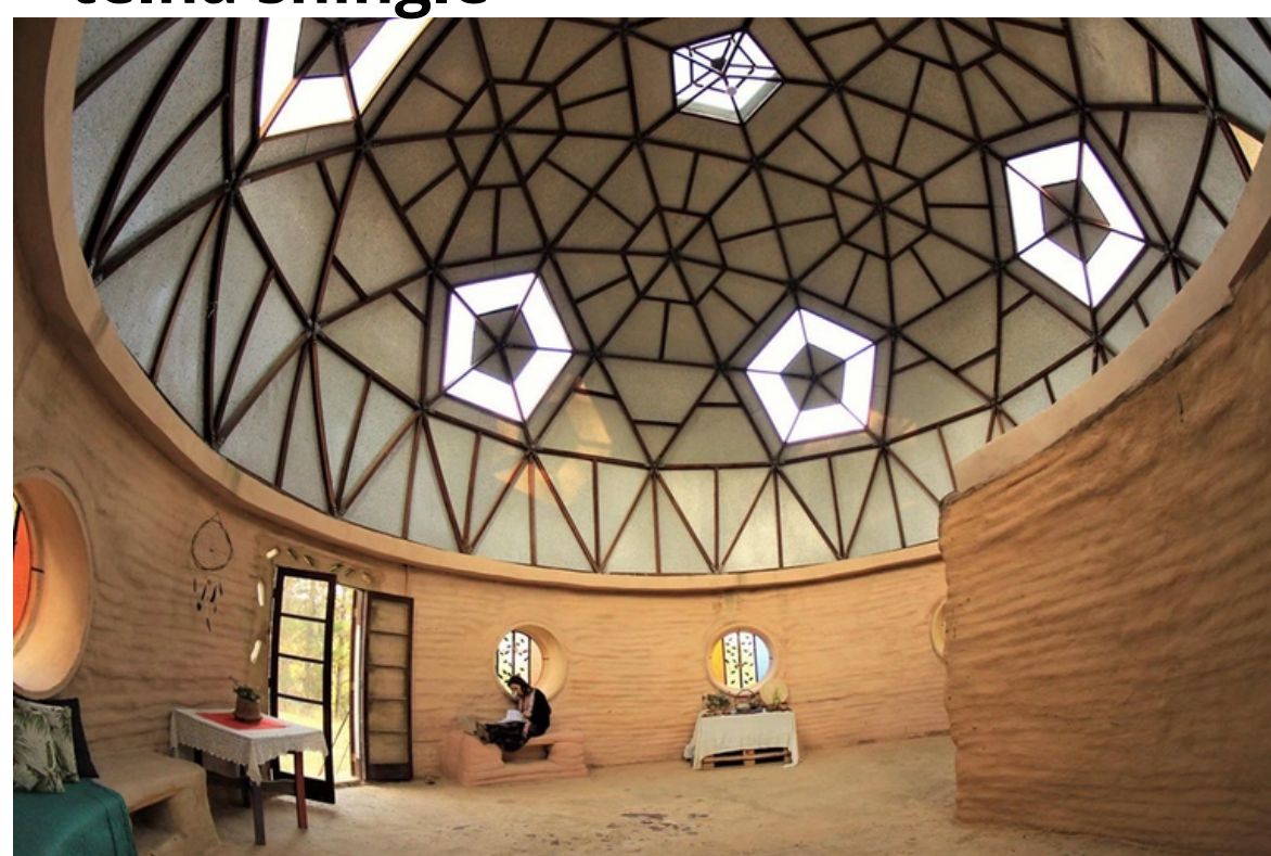
Figura 28 - Geodésica com vedação de telha shingle
