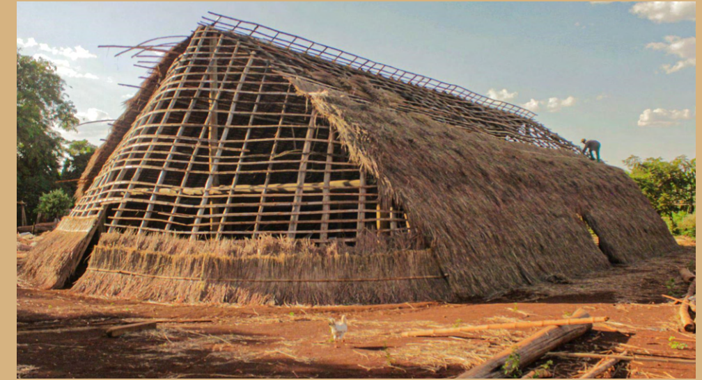
Figura 65: Estrutura de uma casa de reza em construção Fonte: Autoral, 07 de junho de 2023
