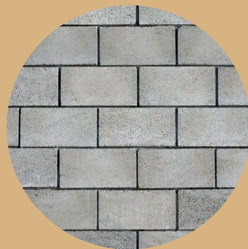
Figura 63: Parede Estrutural de Tijolos de Concreto
