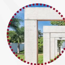
pórticos/pilares em concreto armado
