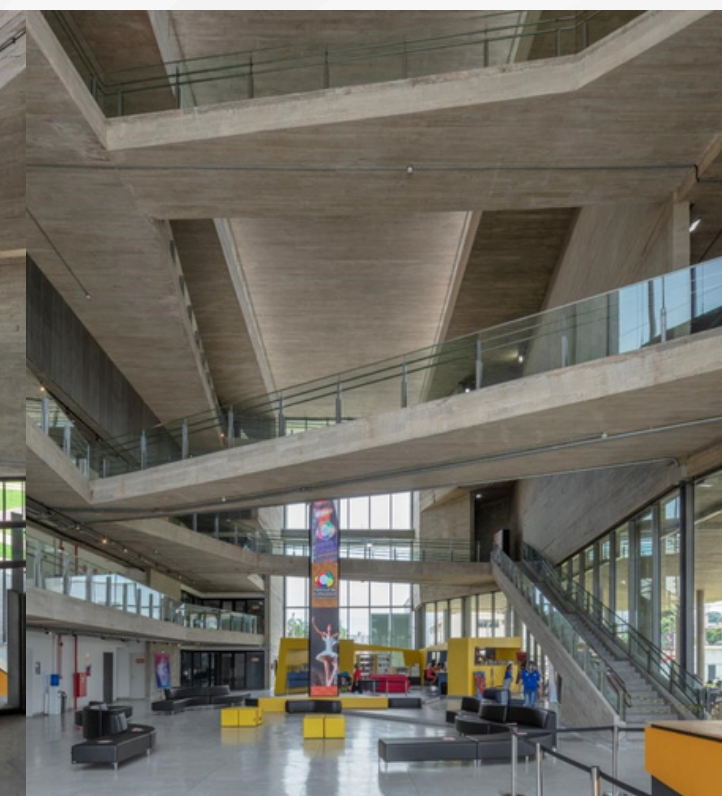
Figura 34 - Vista do térreo
