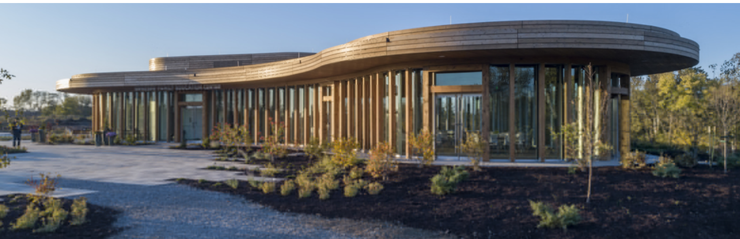
Figura 11 - forma orgânica em fachada
