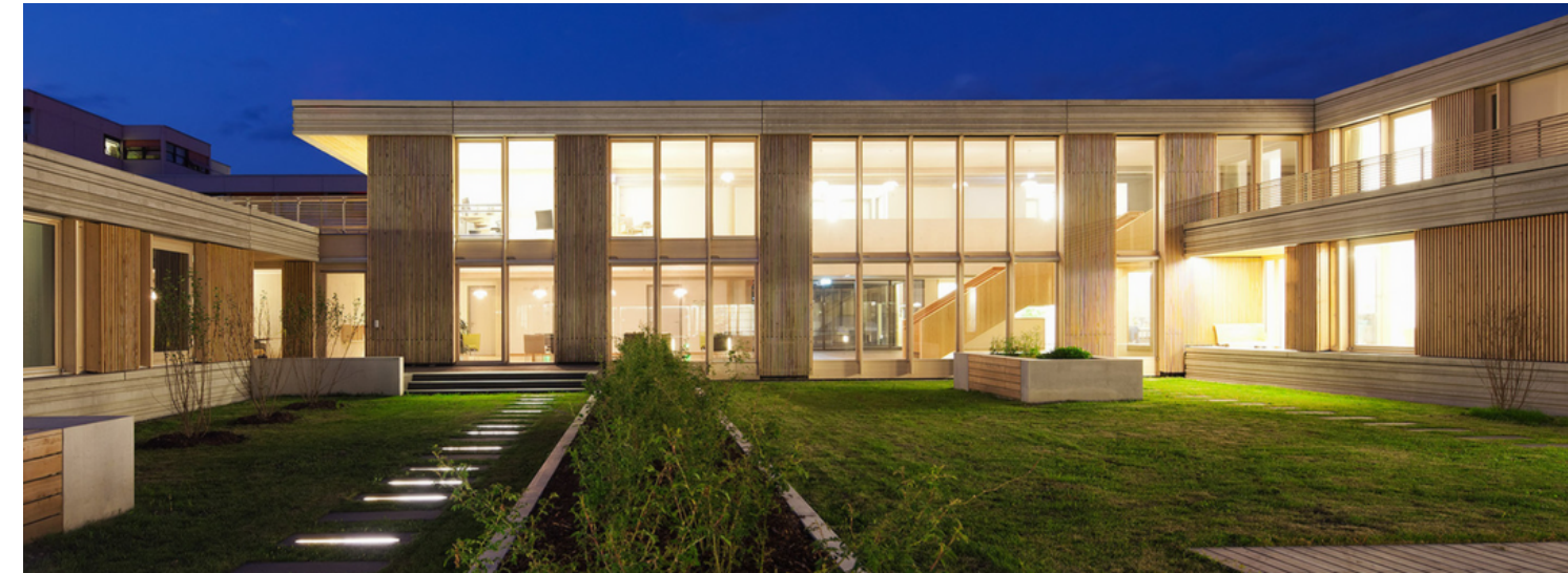
Figura 20 - Pátio Centro Psiquiátrico Friedrichshafen
