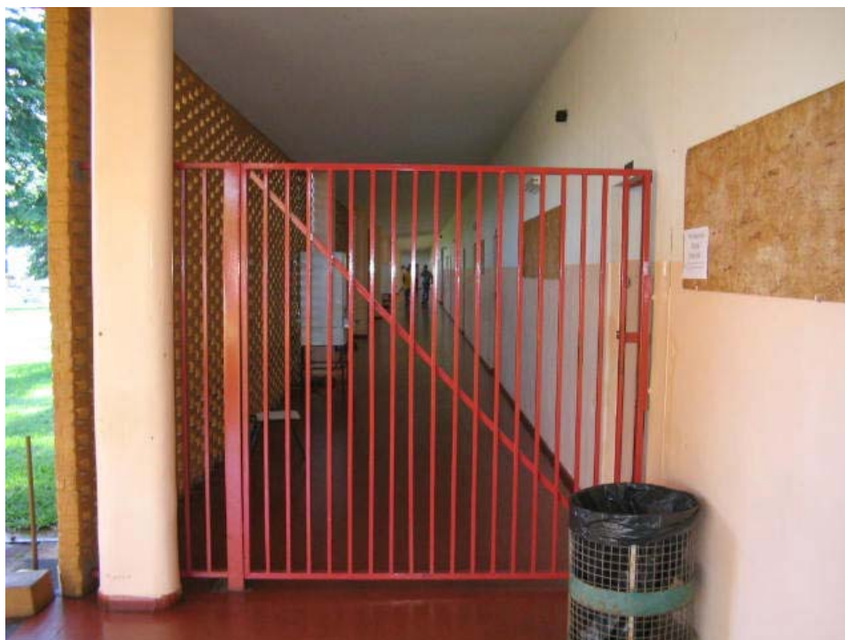
Figura 26. portão que isola o bloco das salas de aula. Foto: Campos (2005)
