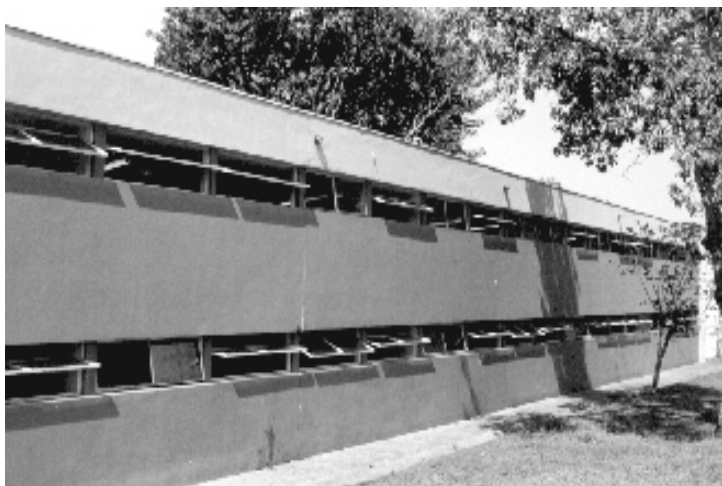
Figura 17. janelas das salas de aula. Fonte: Arruda (2001, p.145)
