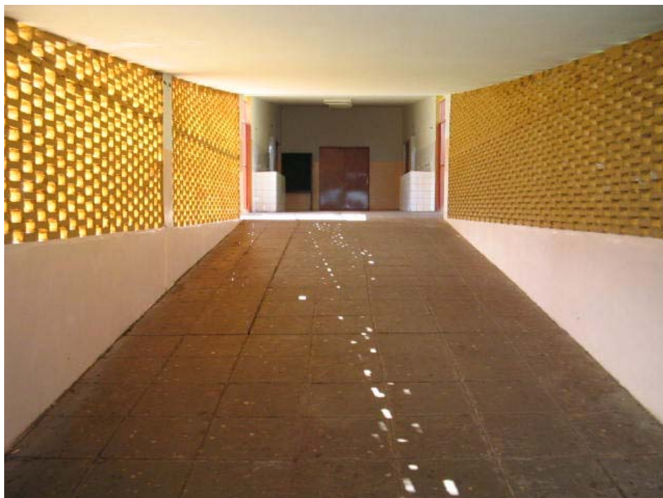
Figura 23. Laterais que dão acesso à cantina (fechamento). Foto:Campos (2005)
