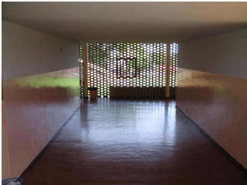
Figura 22. Fechamento da janela ao fundo (cobogó). Foto: Campos (2005)
