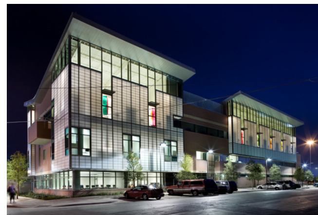
Figura 16: Vista do edifício Bridge Homeless Assistance Center
