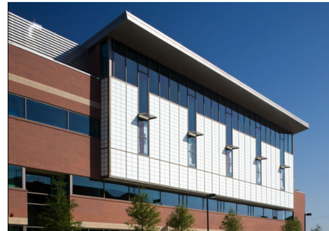
Figura 13: Vista externa evidenciando a iluminação natural
