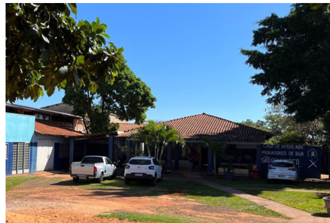
Figura 45: Vista Frontal da edificação
