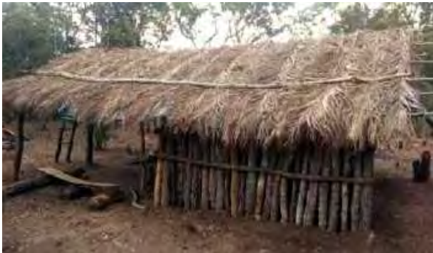
Casa de pau a pique
