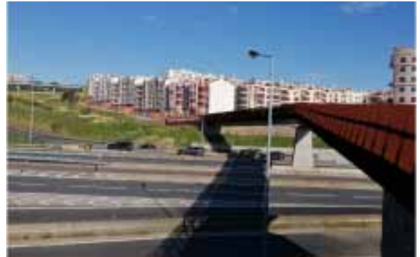
Figura 7 – Passarela sobre IC20. Vista da passarela que atravessa o entroncamento viário e permite conexão entre o Parque da Paz e a freguesia do Pragal, onde o “espaço-entre” foi incorporado ao Parque. Vista da alça viária de acesso a autoestrada A2 em direção a Ponte 25 de Abril à esquerda. Fonte: Foto da autora em fevereiro 2020.
