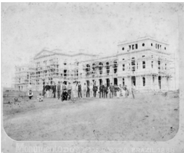
Obras de Construção do Museu do Ipiranga em 1888 Por Not stated - Museu do Ipiranga, Domínio público, https://commons.wikimedia.org/w/index.php?curid=64292990
