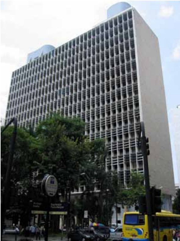
Edifício do Ministério da Educação e Saúde 1937-1945, vista norte. Por Imagens AMB - Enviado pelo autor, Domínio público, https://commons.wikimedia.org/w/index.php?curid=1465902 . Projeto de Lúcio Costa, Carlos Leão, Oscar Niemeyer, Afonso Eduardo Reidy, Ernani Vasconcelos e Jorge Machado Moreira, com consultoria de Le Corbusier.
