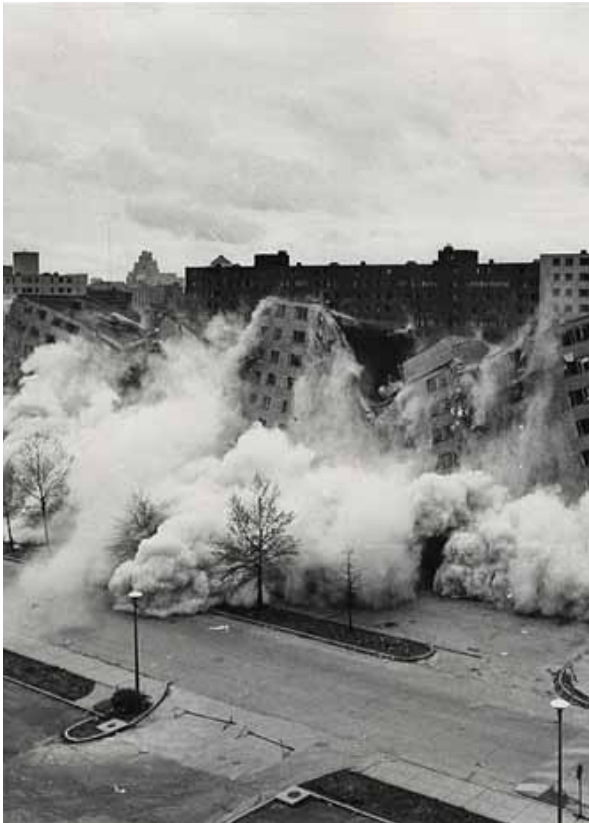
Figura 17 – Demolição do conjunto Pruitt-Igor. Fonte: https://pt.m.wikipedia.org/wiki/Ficheiro:Pruitt-Igoe-collapses.jpg . Acesso em: 03 de nov. de 2021.
