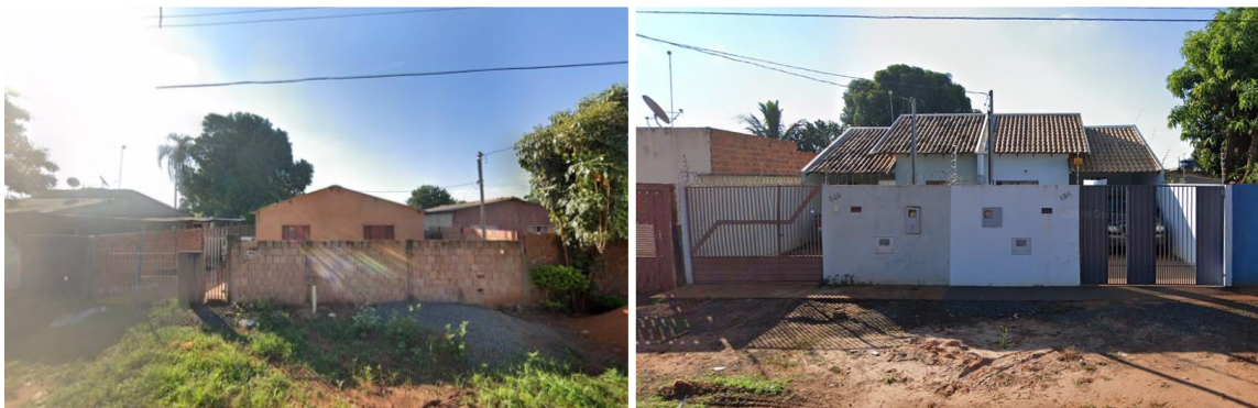
Figura 8 - Casas no loteamento Parque do Lageado
