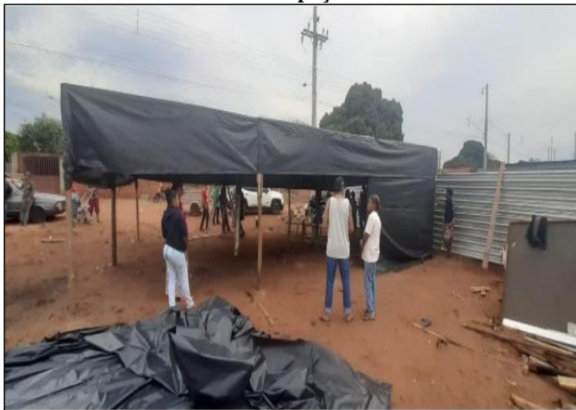
Figura 47 - Três Lagoas (MS) / Ocupação São João: reconstrução coletiva das estruturas da ocupação
