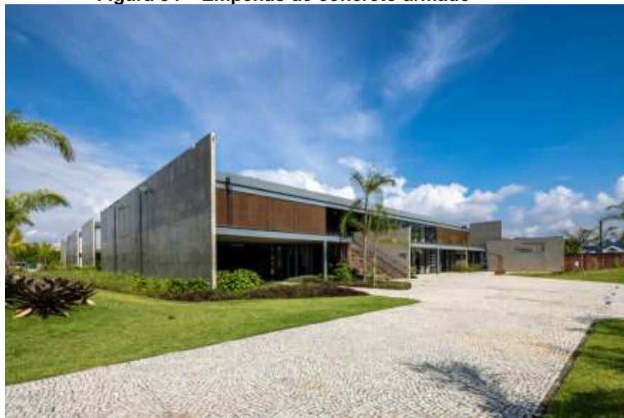
Figura 34 – Empenas de concreto armado
