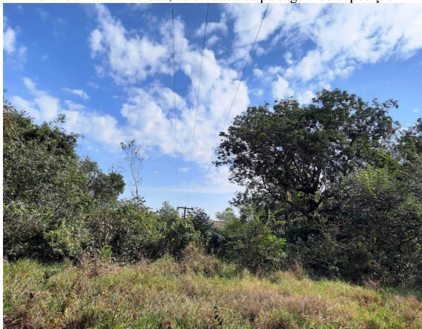
Figura 28. Falta de limpeza dos aceiros das linhas de alta tensão que cortam as APPs da BHCB, na fazenda Barra Dourada, na unidade da paisagem de deposição.
