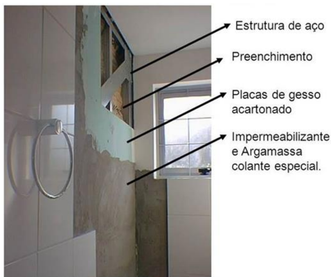
Figura 5 - Ordem de aplicação dos materiais do sistema.
