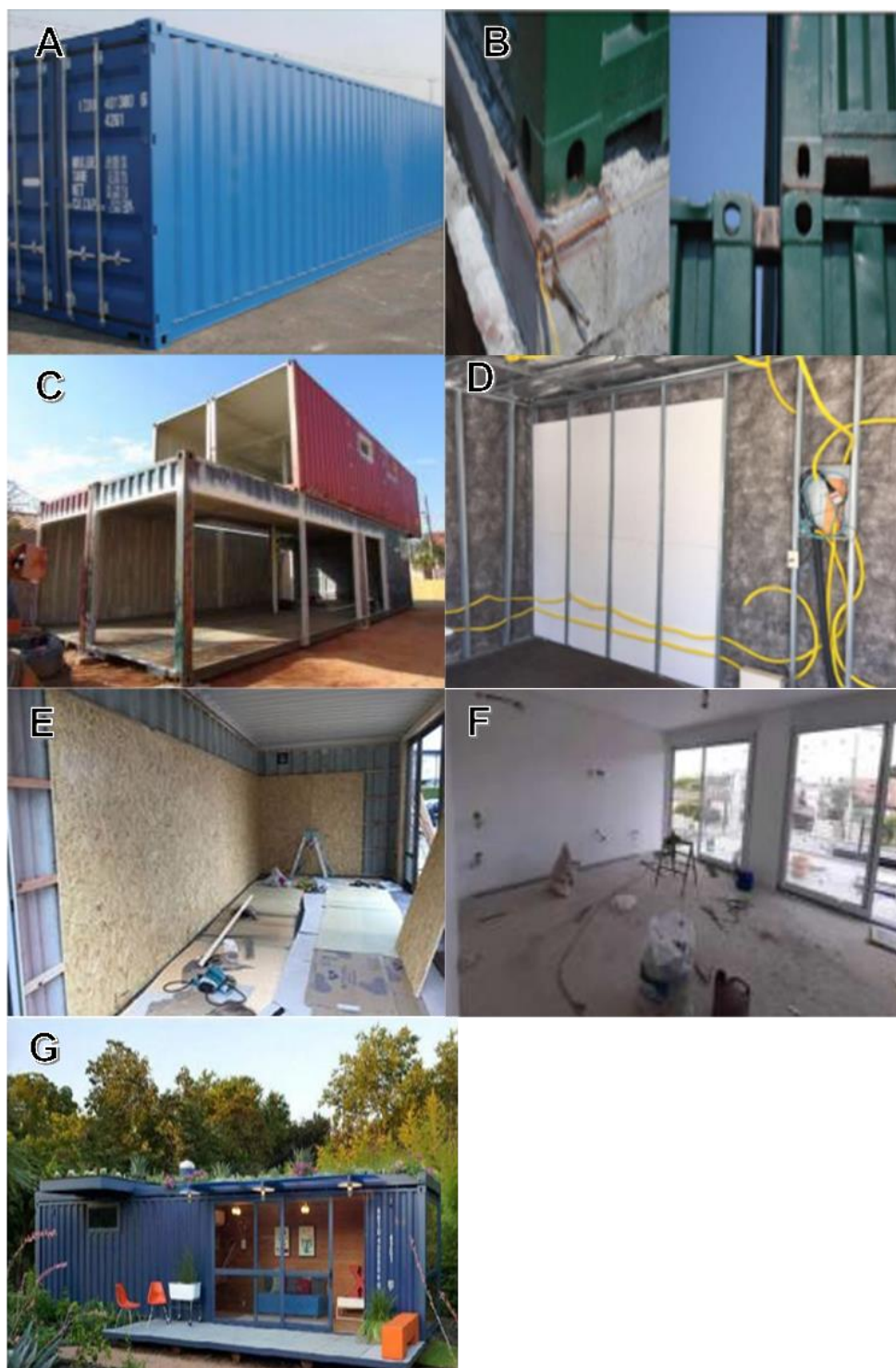
Figura 14 - Processo de execução e utilização de alguns materiais da alternativa construtiva; (A) Contêiner no local da obra; (B) realização da fundação; (C) recorte para as esquadrias; (D) instalações elétricas e hidráulicas e lã pet (E) aplicação das placas de acabamento; (F) finalização do acabamento com placas de gesso e forro de gesso; (G) construção finalizada.
