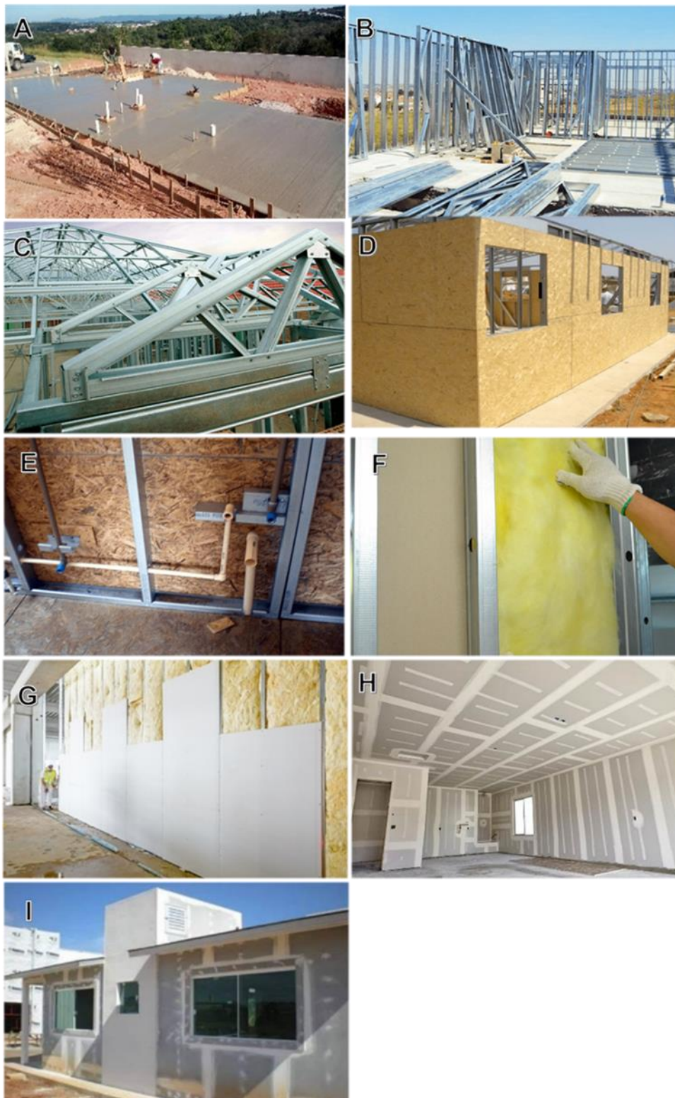
Figura 4 - Processo de execução e utilização de alguns materiais, sendo: (A) a execução da fundação radier; (B) montagem dos painéis sobre a fundação já pronta; (C) montagem da estrutura do telhado; (D) plaqueamento externo com placas do material OSB; (E) instalações hidráulicas e elétricas; (F) instalação da lã termoacústica; (G) plaqueamento interno com placas de gesso; (H) plaqueamento interno já finalizado; (I) fase de acabamento.
