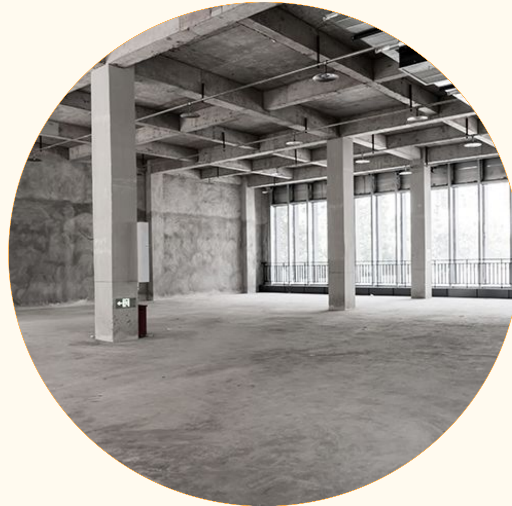
PILARES EM CONCRETO
