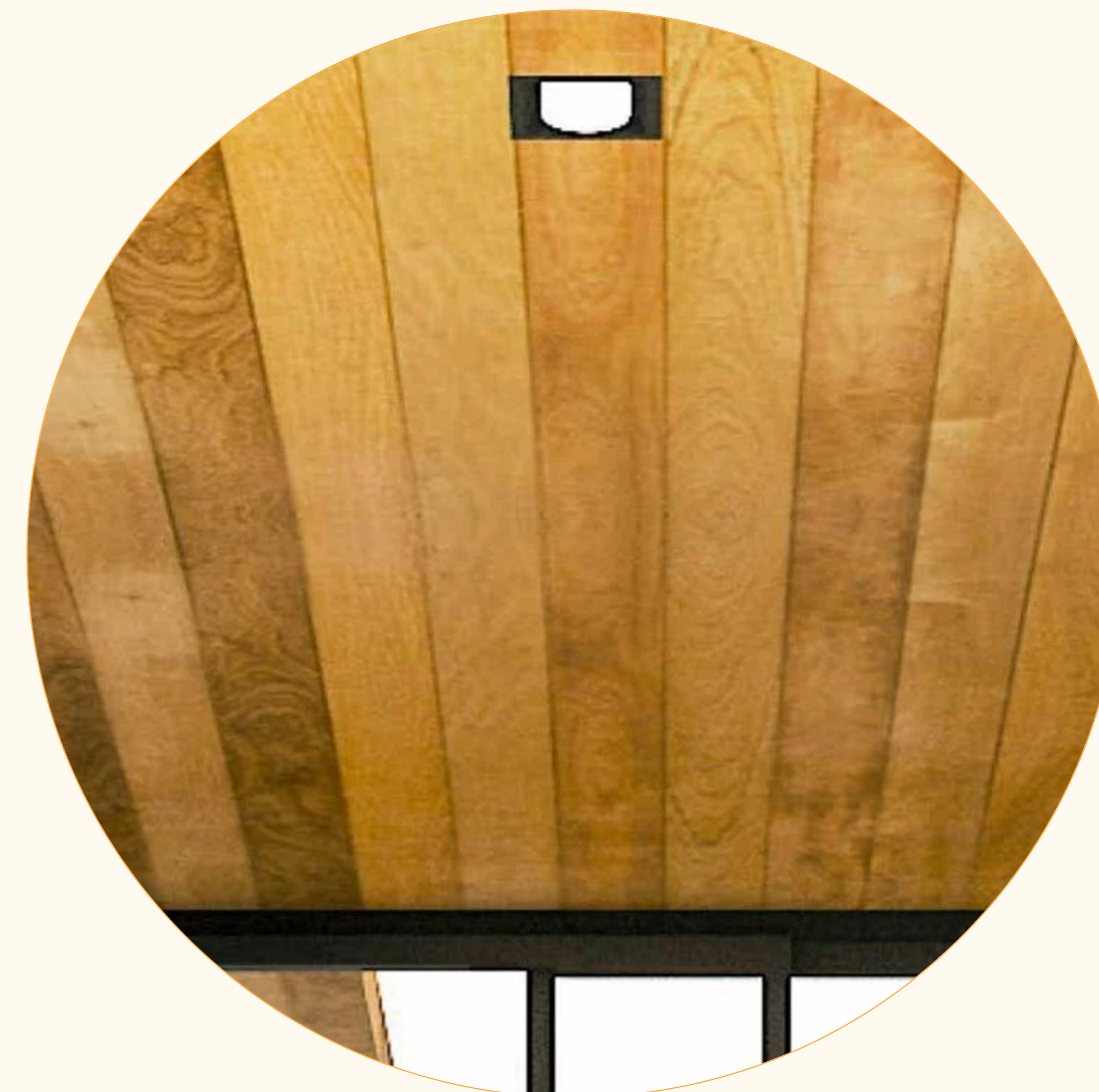
FORRO EM LAMBRI DE MADEIRA
