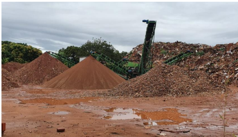
Figura 34 - Produção paralisada devido à chuva
