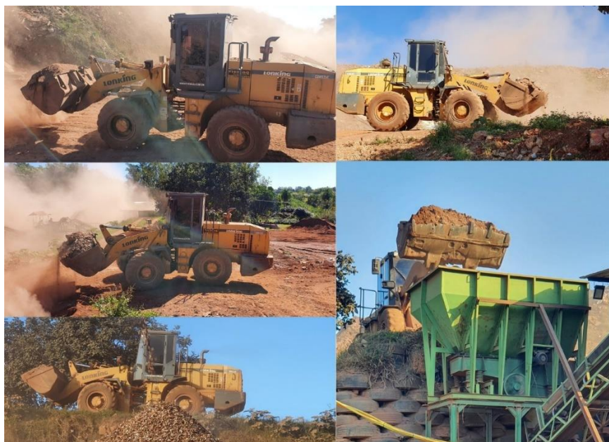
Figura 20 - Pá carregadeira com volume superior a capacidade da concha
