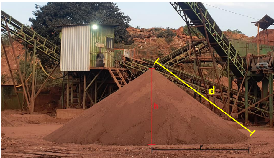
Figura 21 - Cone formado pela deposição natural do agregado reciclado de RCC
