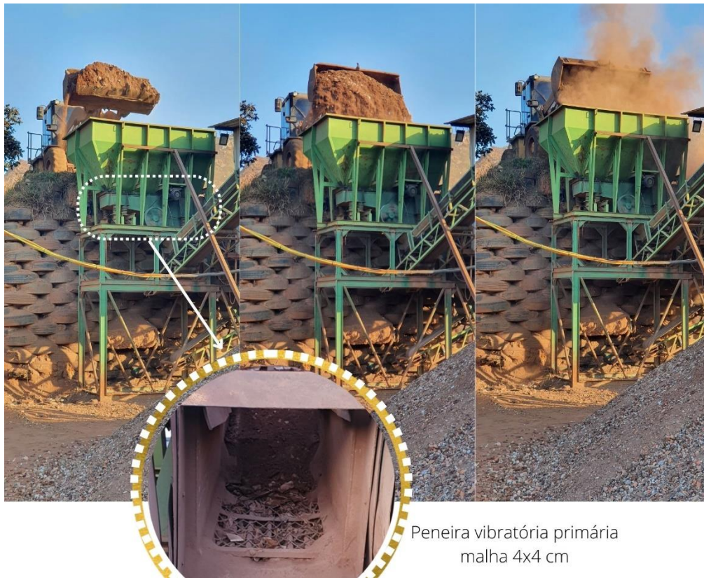
Figura 28 - Alimentação do equipamento com a pá carregadeira
