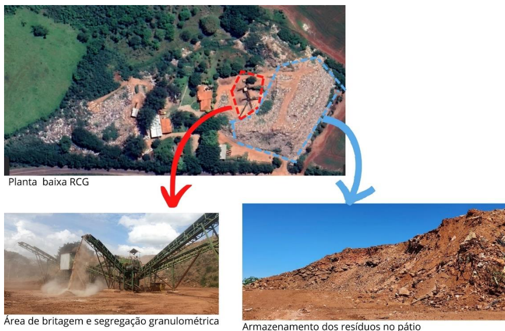
Figura 23 - Resíduo armazenado no pátio aguardando segregação e britagem
