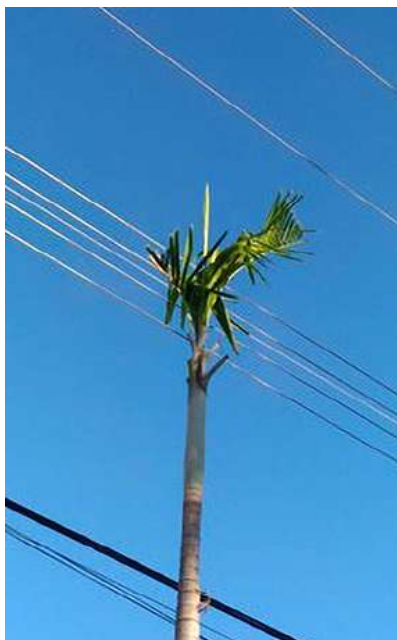
Figura 2.9 – Palmeira plantada sob fiação elétrica.
