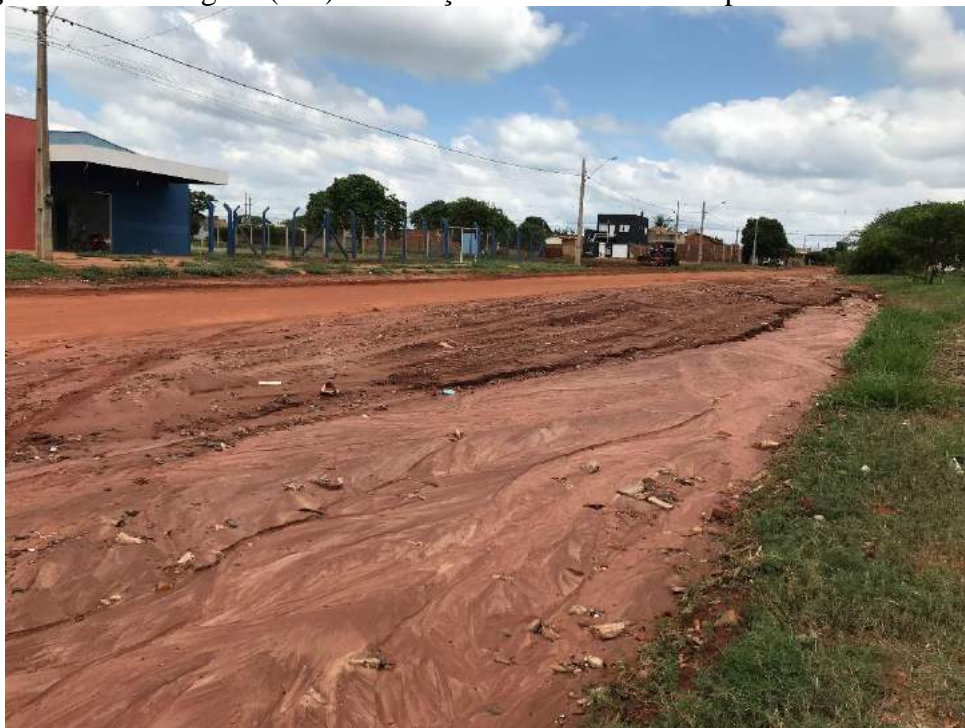
Imagem 14: Três Lagoas (MS): utilização de terra vermelha para assentamento da rua
