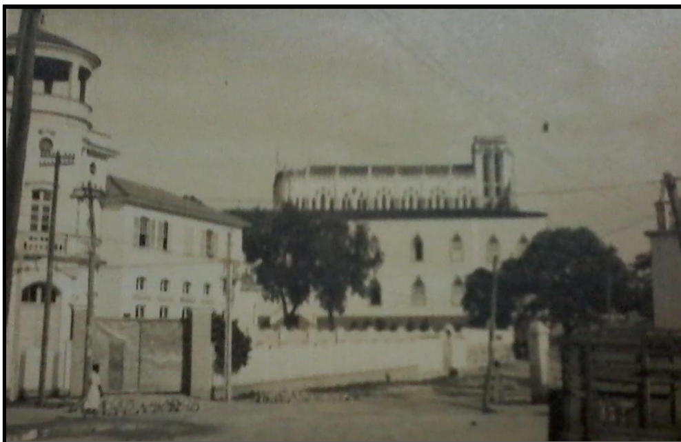
FIGURA 10 – Prédio no qual se instalou a EDMA
