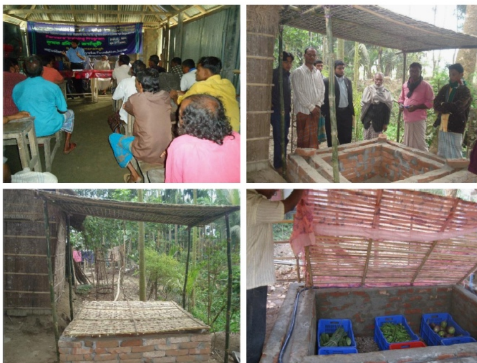
Figura 2. Resfriador evaporativo de parede de tijolos cerâmicos, para aproximadamente 100 kg de frutas e hortaliças, em Bangladesh
