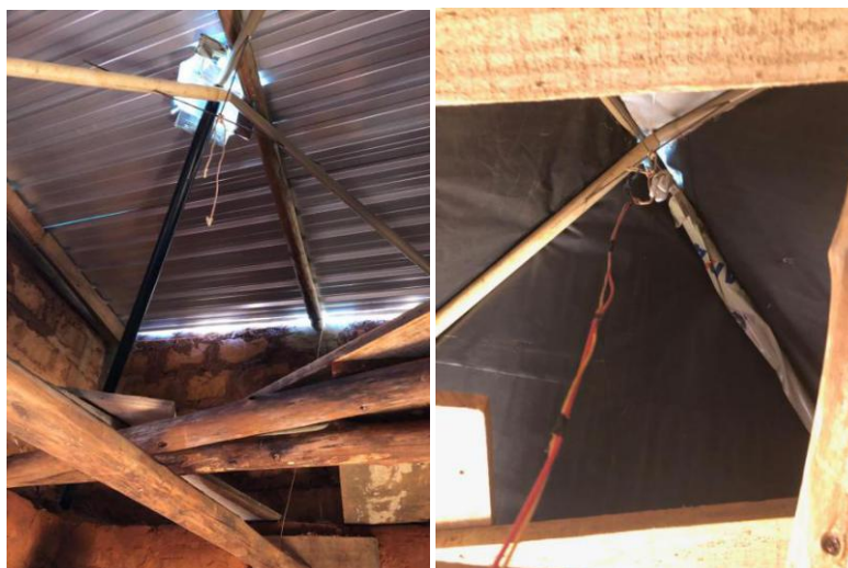
Figura 49. Execução da coifa.
