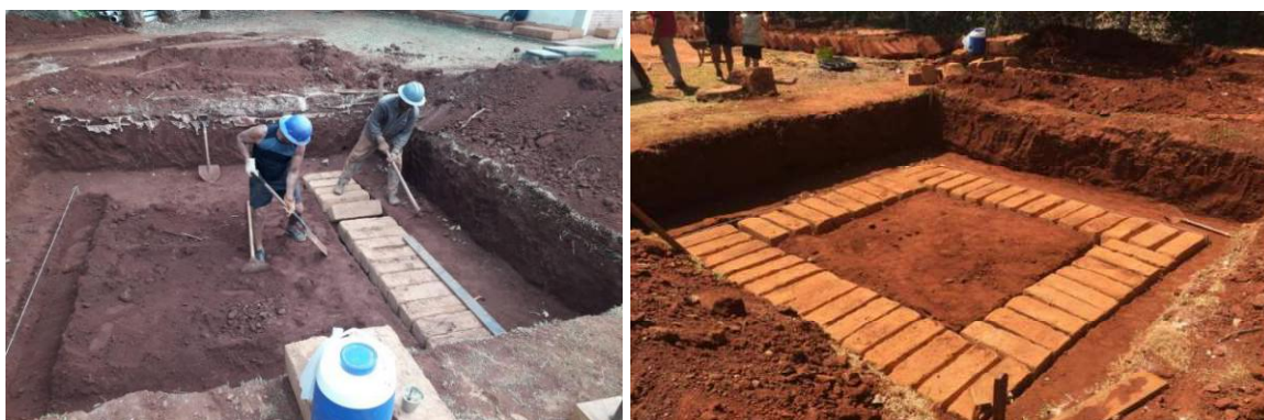
Figura 45. Execução de fundação.
