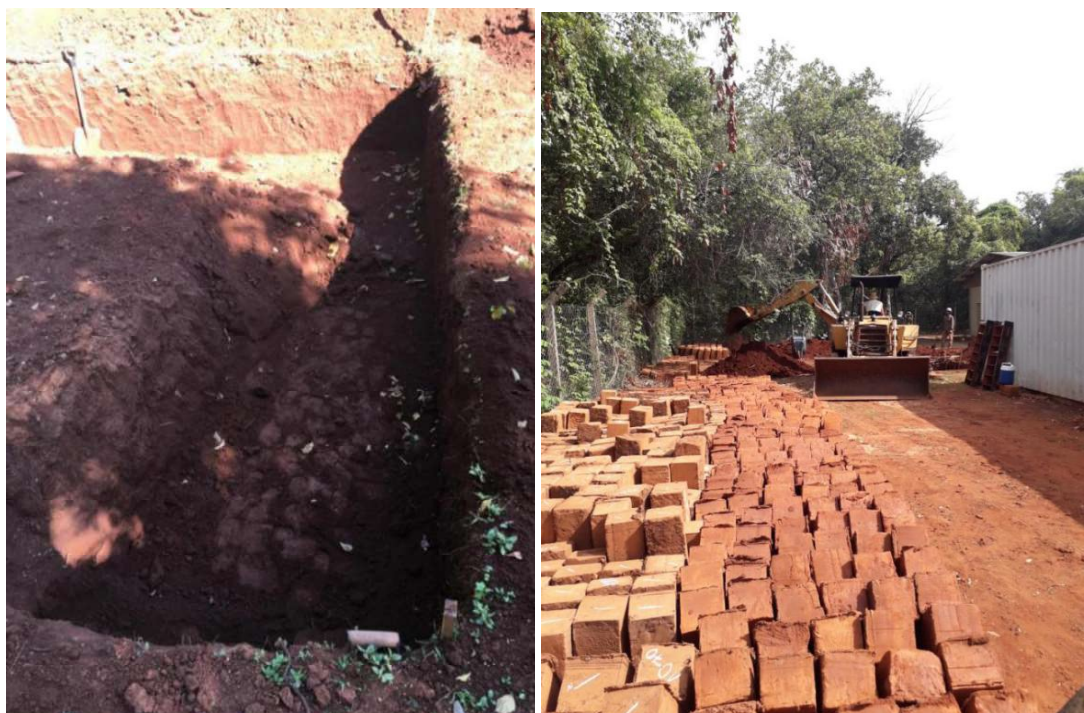
Figura 44. Escavação de vala para fundação.
