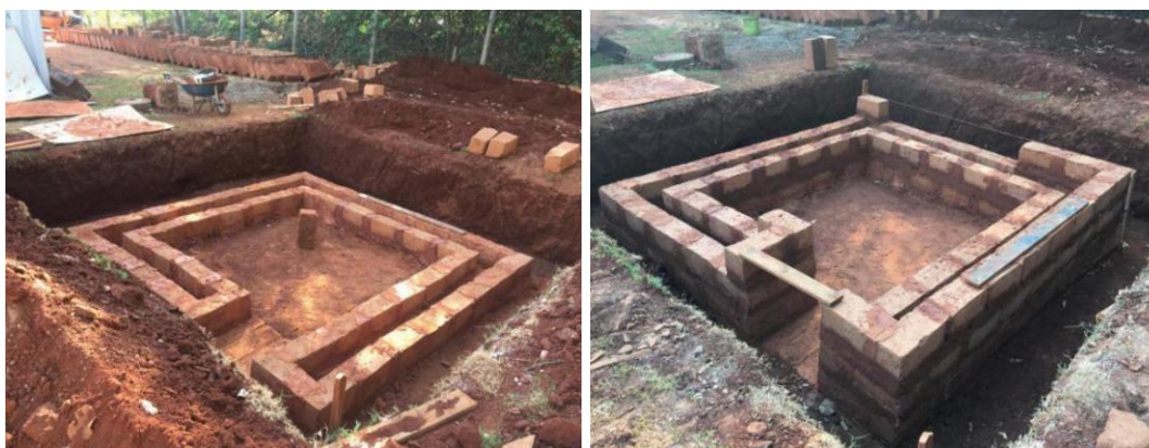
Figura 46. Execução das paredes duplas.
