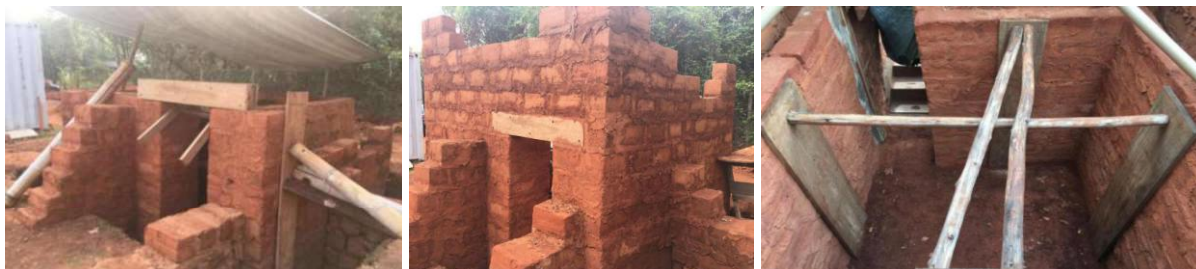
Figura 47. Verga e contenções internas.
