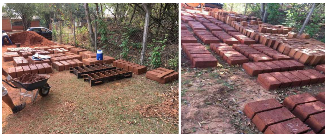
Figura 43. Fabricação e cura dos adobes.
