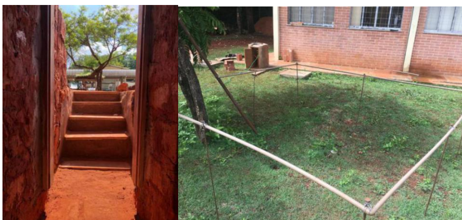
Figura 50. Porta, escada e tubulação em teste da instalação hidráulica.
