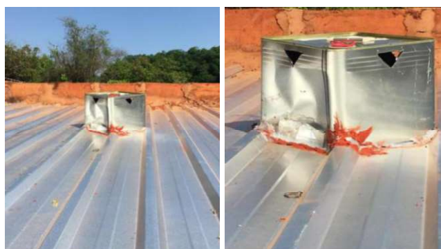
Figura 48. Instalação de cobertura e chaminé metálicos.
