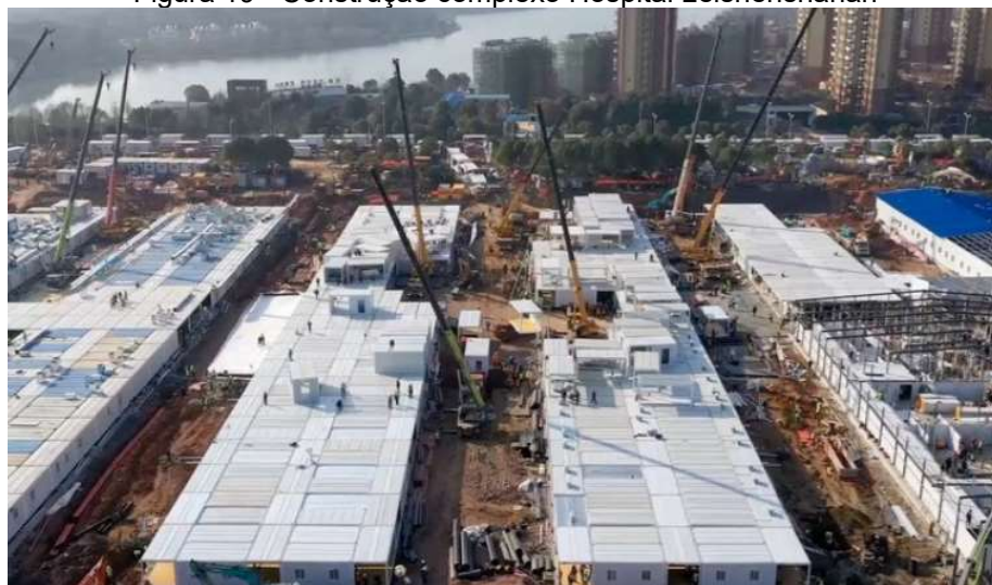
Figura 19 - Construção complexo Hospital Leishenshan
