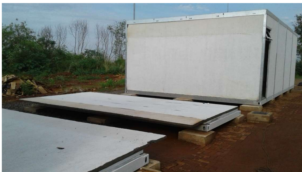
Figura 24 – Painéis montagem sala modular IFMS Campo Grande
