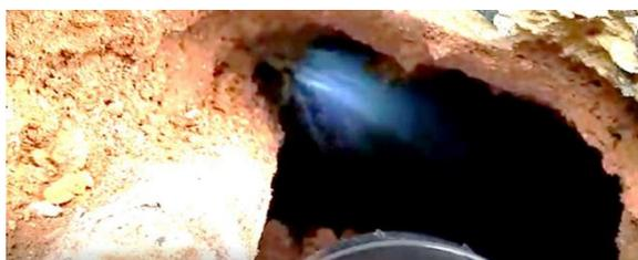
Figura 14: Tubulação com vazamento de grande intensidade
