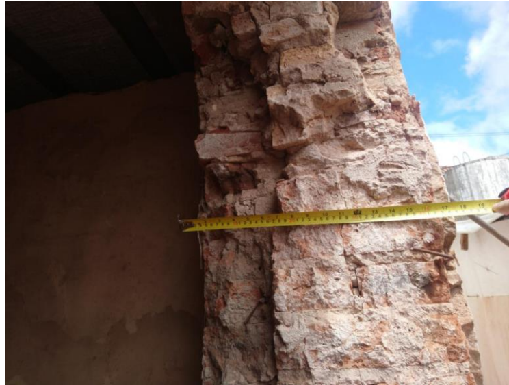
Figura 41 – Parede de espessura 45 cm.
