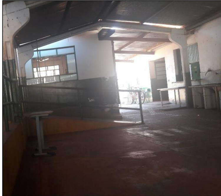
Figura 3 - Entrada lateral e rampa de acesso às salas de aula, banheiros e cantina Fonte: Arquivo pessoal da autora (2019).
