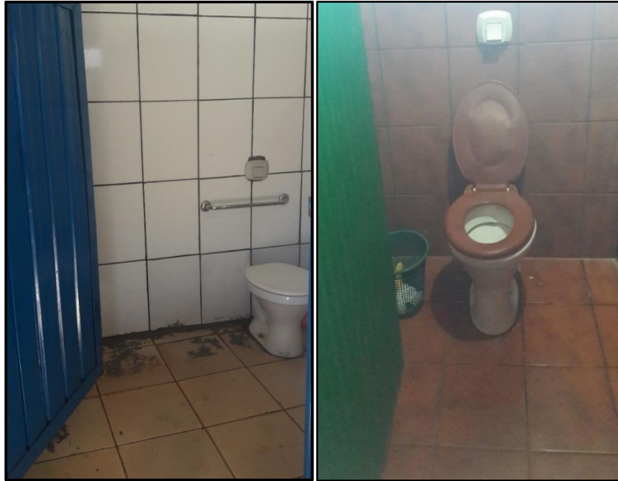
Figura 14 - Estrutura dos banheiros Fonte: Arquivo pessoal da autora (2019).
