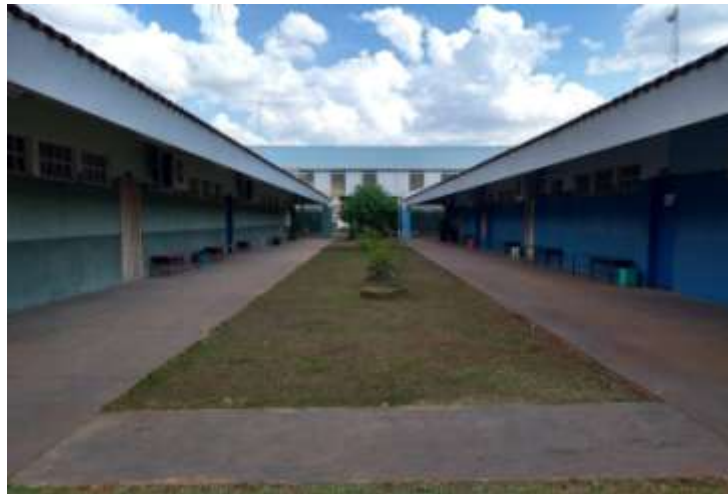
Figura 3- Dependências da Escola - espaço entre pavilhões (PAIXÃO, 2018)
