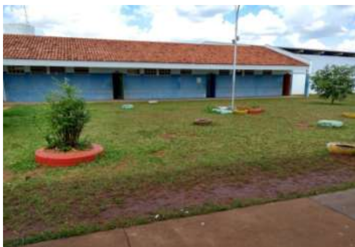
Figura 2- Dependências da Escola - espaço entre pavilhões (PAIXÃO, 2018)
