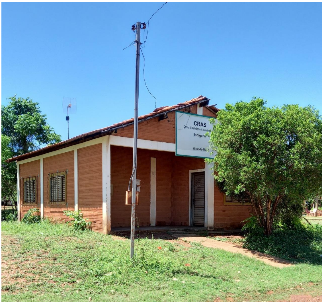
Figura 3: Prédio do CRAS. Foto: autora, 2021.
