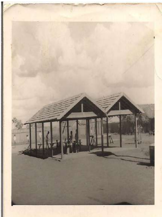
Figura 7. Área coberta para recreio
