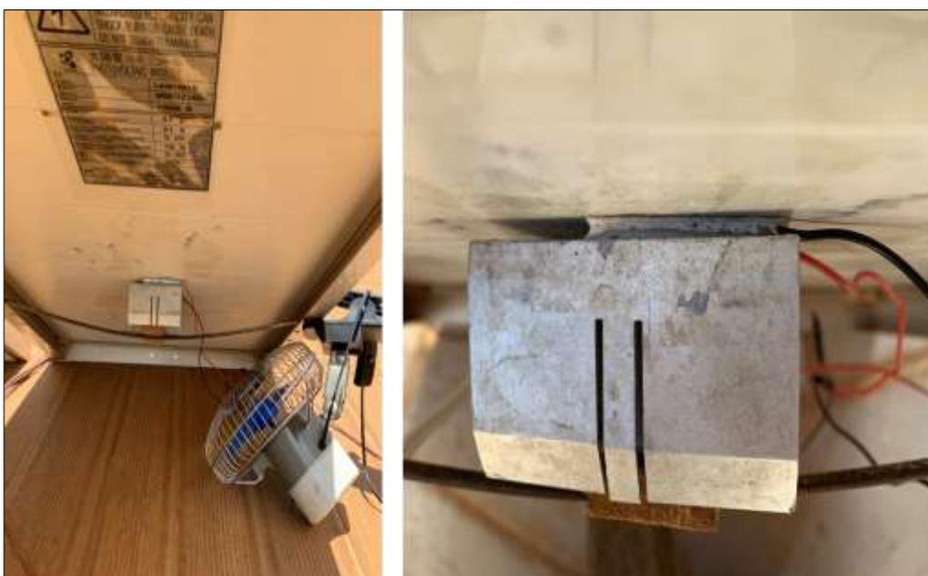
**Figura 19** – Detalhe da placa Peltier e do dissipador de calor.
