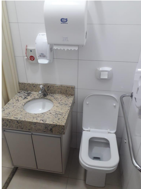
Figura 2. Acionador da descarga do banheiro.
