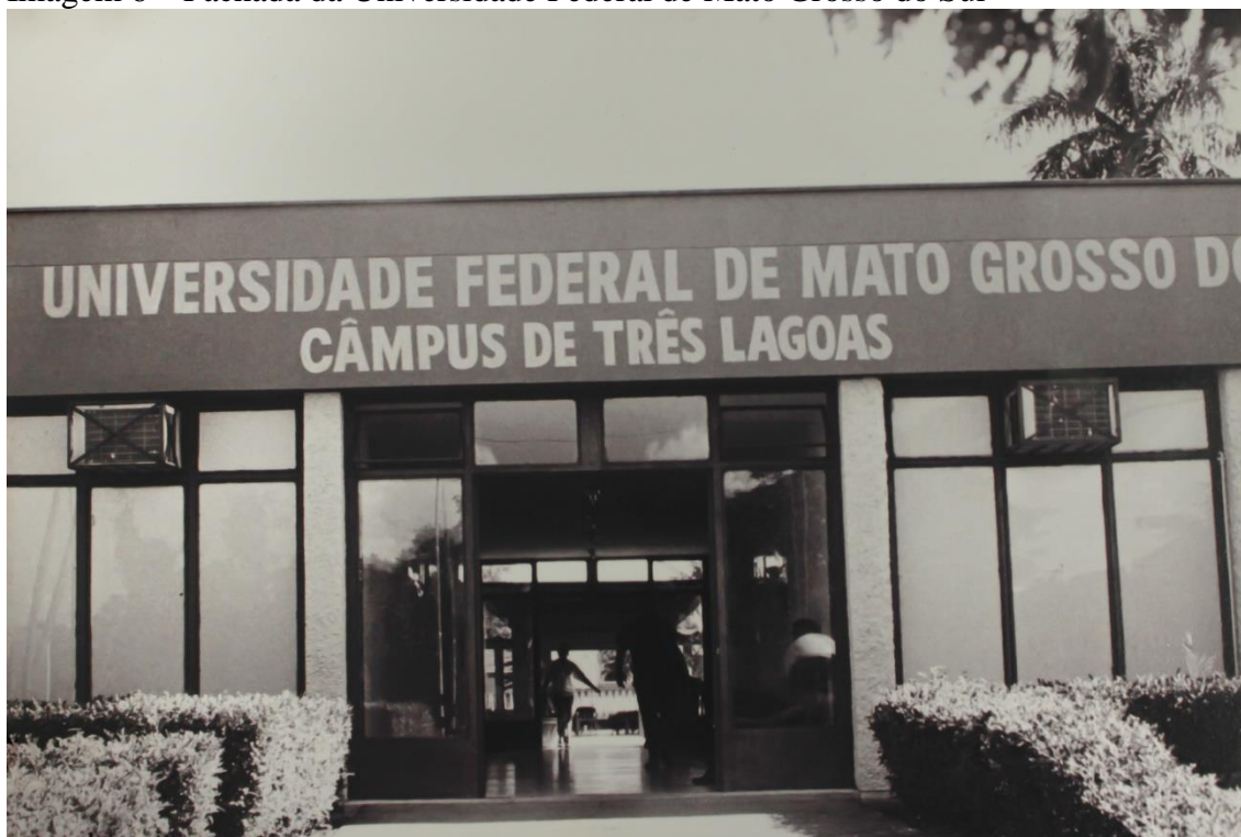
Imagem 6 – Fachada da Universidade Federal de Mato Grosso do Sul
