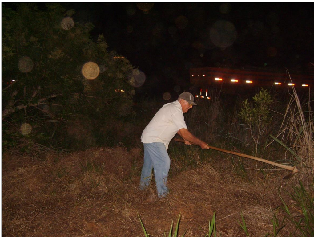
Figura 5 – Limpeza do local para construção do acampamento no Córrego do Moeda
