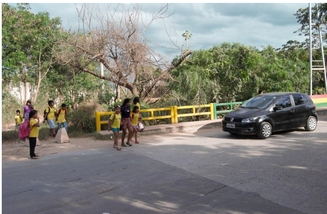
Figura 2 - Ponte sobre o Arroyo Concepción
