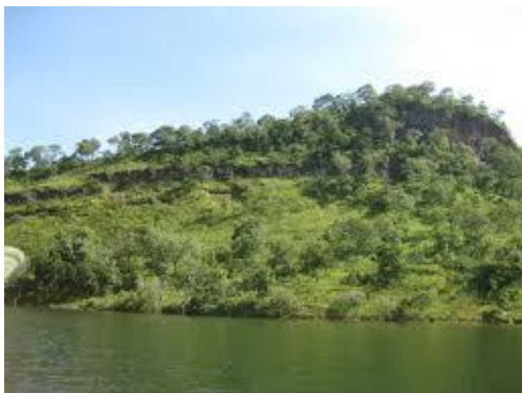
Figura 13 - Estrutura vegetacional protegendo a encosta. Fonte: suoli.com.br (2015)
