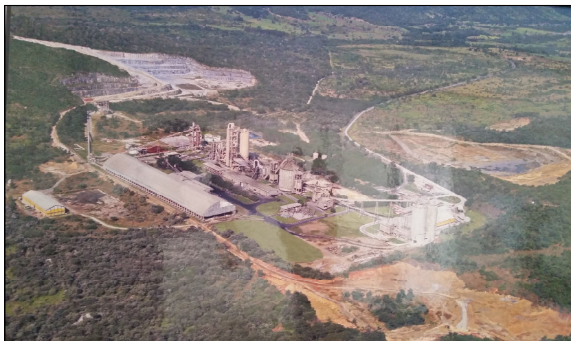
Figura 7 – Complexo Industrial da Empresa 2
