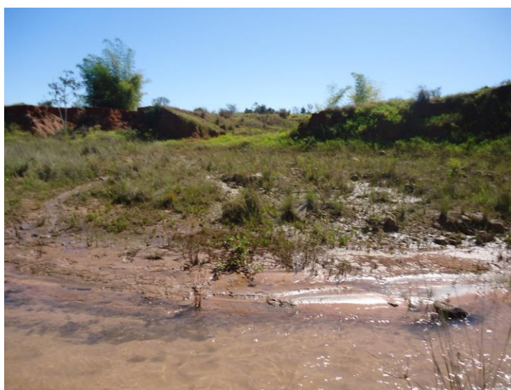
Figura 76: Ponto 4 de análise das águas na bacia do Ribeirãozinho. Local de erosões marginais, solo exposto e erosões hídricas nas APPs e margens do córrego.
