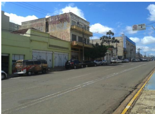
Foto 26 - De outro lado aparecem edifícios desocupados Fonte: Autor, 2016.
