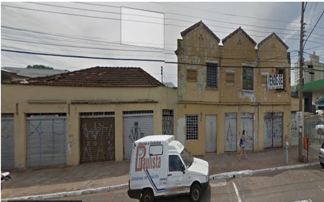
Foto 19 - Edificações abandonadas na esquina com a Rua Maracaju Fonte: Google, 2016
