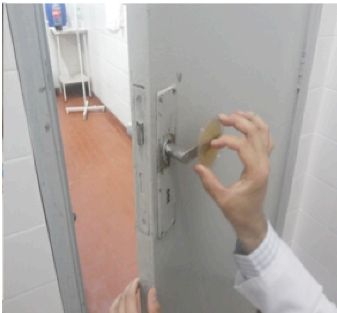
Figura 8 - Vista panorâmica da maçaneta interna do banheiro
