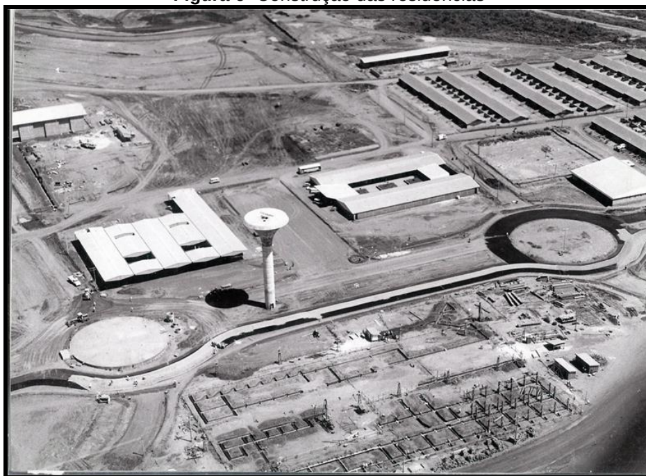
Figura 6- Construção das residências
