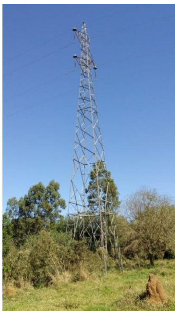
Imagem 4.1 - Fotografia da torre de transmissão de energia
