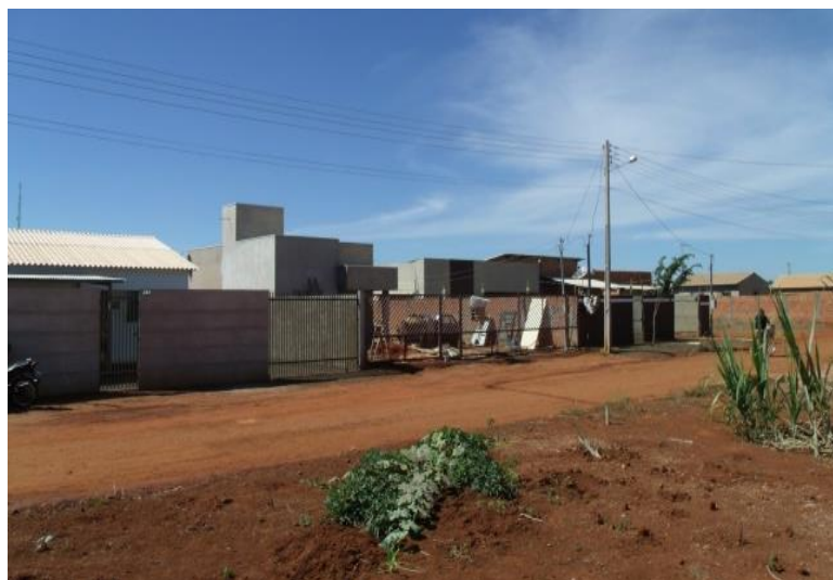
Figura 7 - Casas em fase de construção em Chapadão do Sul. Fonte: OBAL, K. K., 2011.
